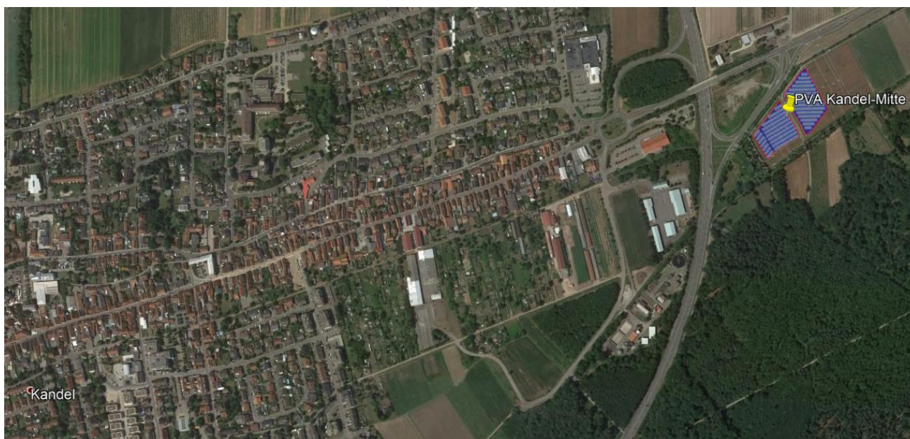
Bild 2.1.1: Luftbild der PV Anlage (Quelle: Google Earth / SolPEG)
