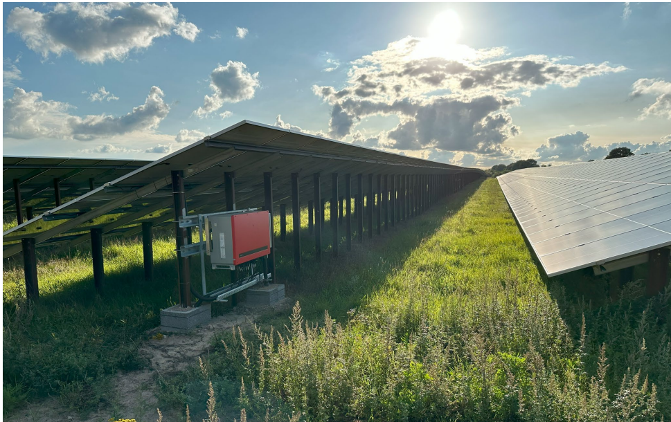
Abbildung 17: Beispiel Modultisch und Wechselrichter (Quelle: EE-Plan GmbH)
