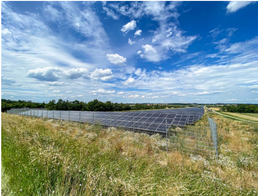
Abbildung 19: Beispiel Einfriedung einer FF-PVA (Foto: EE-Plan, April 2020)
