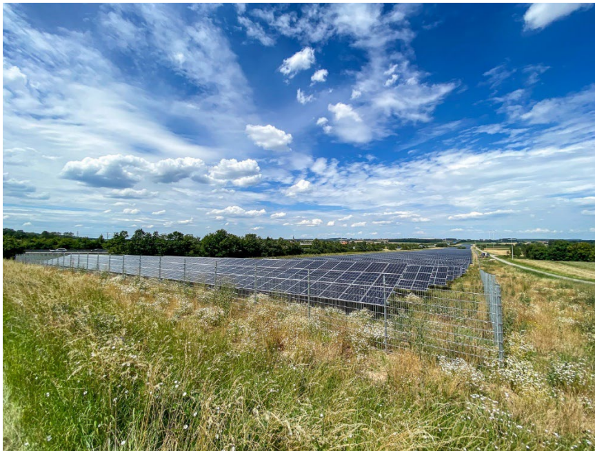
Abbildung 19: Beispiel Einfriedung einer FF-PVA (Foto: EE-Plan, April 2020)
