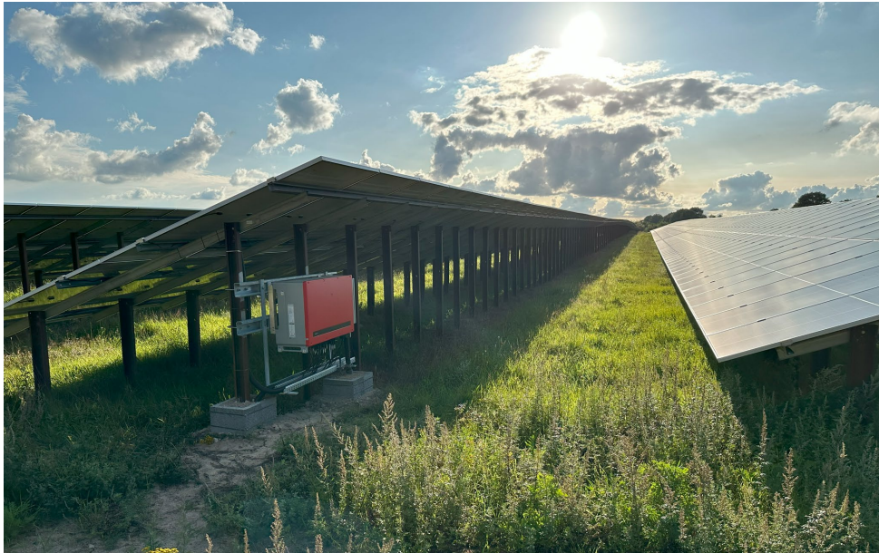
Abbildung 17: Beispiel Modultisch und Wechselrichter (Quelle: EE-Plan GmbH)
