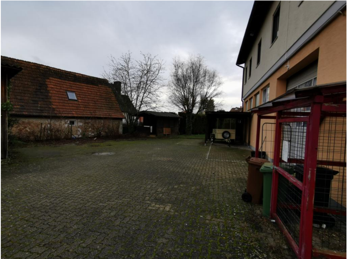
Abbildung 14: Gepflasterte Hintere Stellflächen
