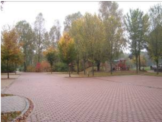
Auf die Parkplatzanlage entfielen die meisten Kosten.
