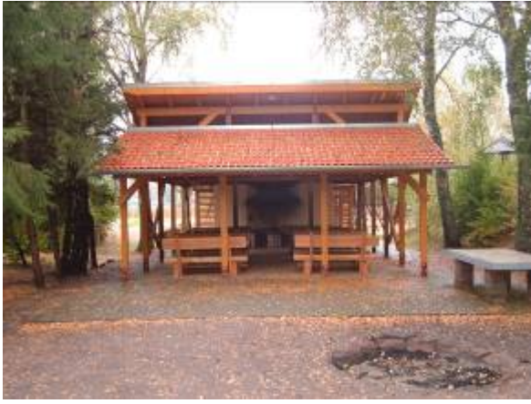
Grillhütte am Barfußpfad.
